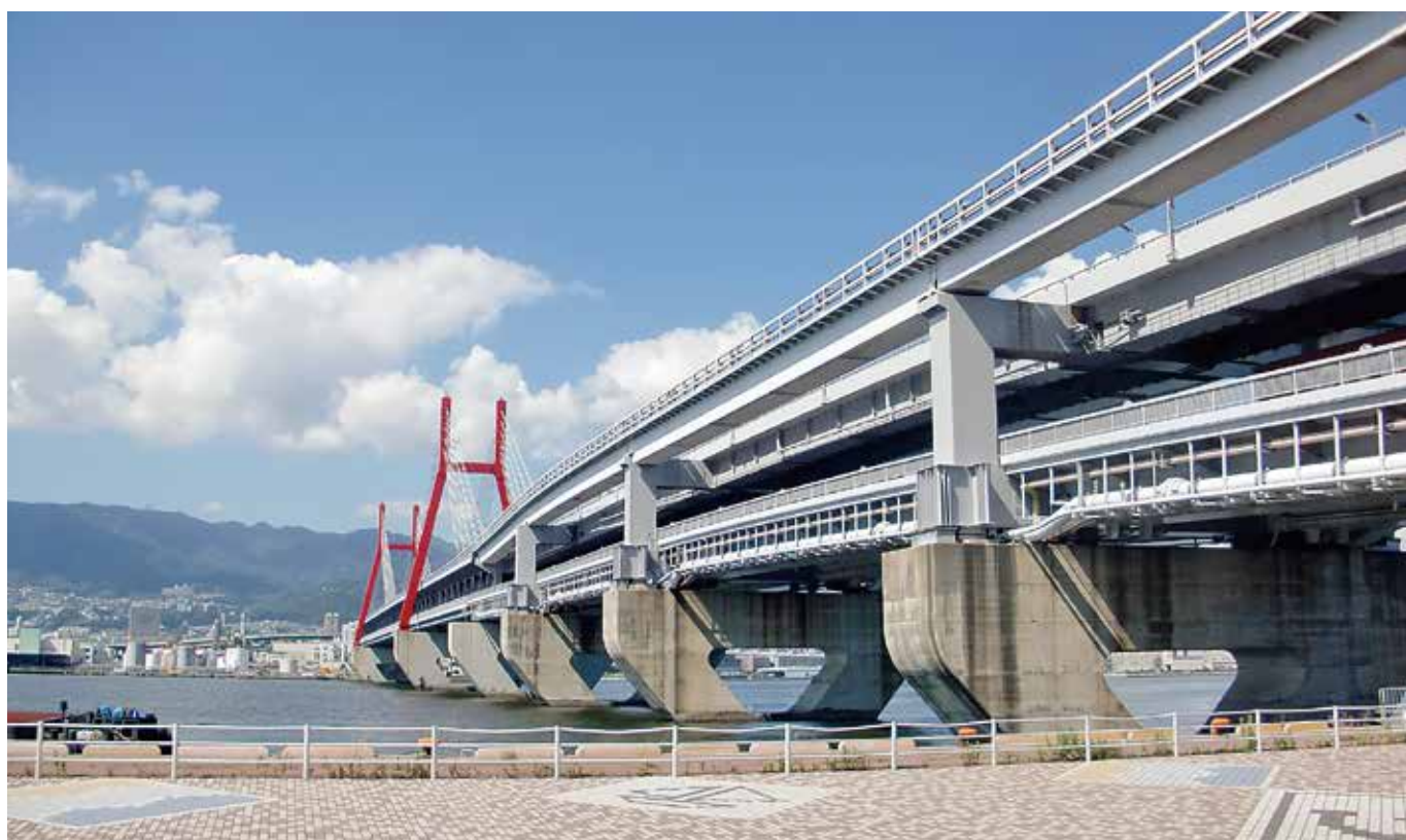
●六甲大橋添架ガス管 300A×750m×2 34年経過（2015.8撮影）
