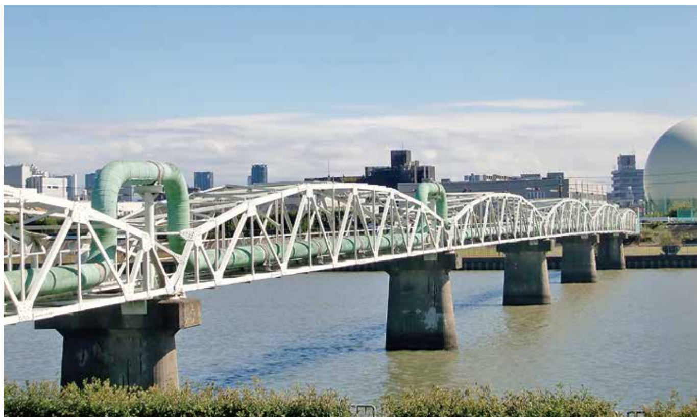
●神崎川ガス管橋（大阪）500A×175m 32年経過（2015.8撮影）
