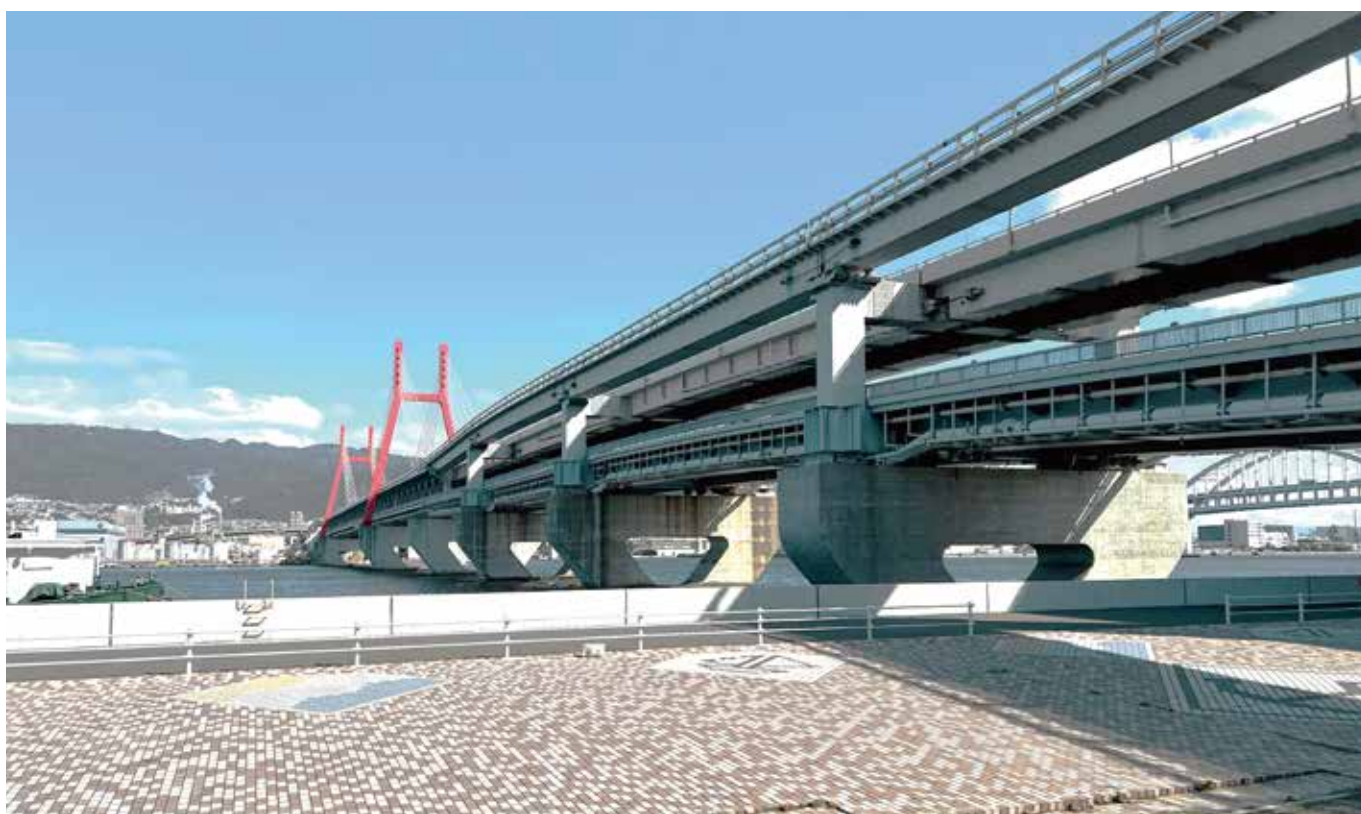
●六甲大橋添架ガス管 300A×750m（西側） 43年経過（2024.3月撮影）
