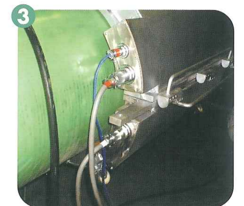
制御ケーブル取付
